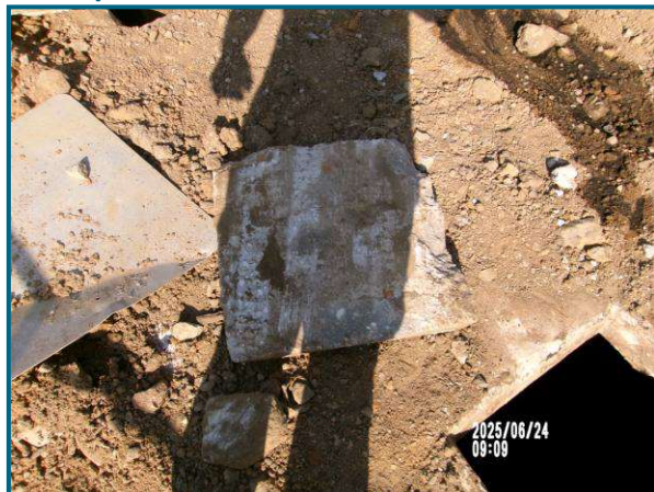
P3. Septic Tank Inlet Lid
